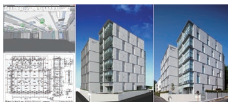
国土交通省初のBIM試行プロジェクト、新宿労働総合庁舎の基準階室内と見上図（左）、BIMモデル（中央）、完成した建物（右）
