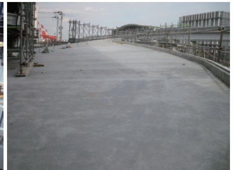
工事所での鉄骨や型枠の組み立て作業(左)。コンクリート打設で設計イメージ通りの曲面を表現した(右)
