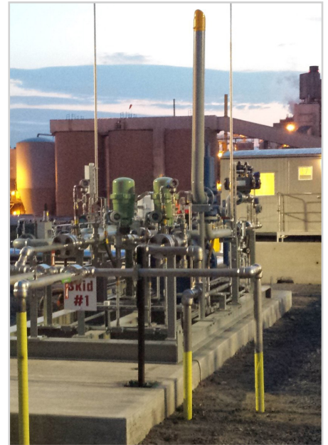
画像提供：Process Pipeline Services 社
